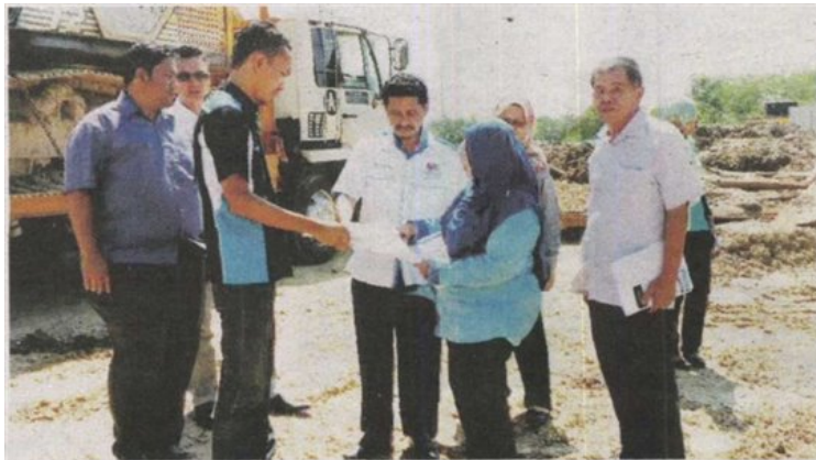
Abdullah Sani melihat pelan pembinaan Projek Kolam Takungan Air Pekan Banting Fasa 1 bersama sebahagian wakil JPS.
